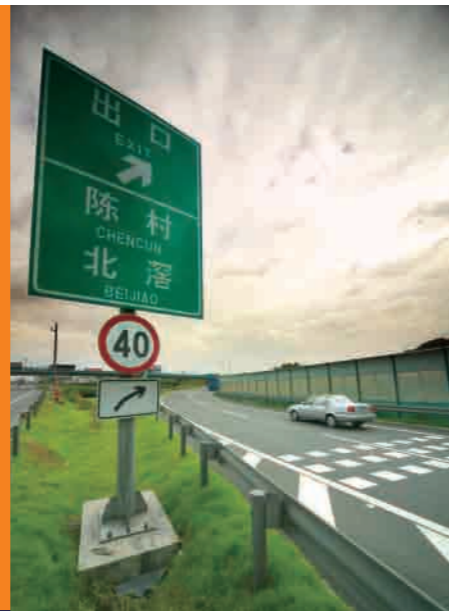
連接廣州至順德的珠江三角洲西岸幹道第I期
