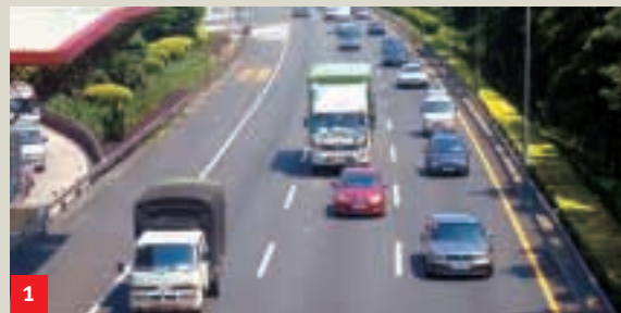
1 廣州 - 深圳高速公路 全線總長 122.8 公里封閉式瀝青鋪設之雙向三車道高速公路，由深圳市皇崗至廣州市廣氮，連接廣州東南西環高速公路。
