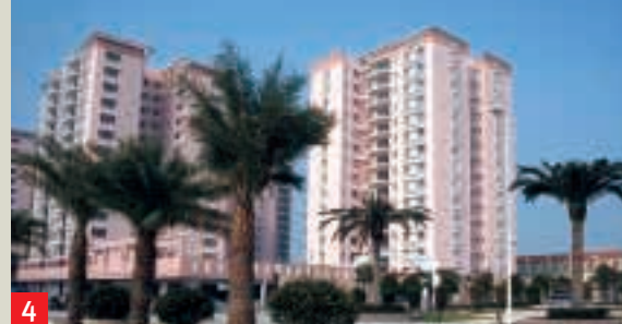
4 合和新城 位於廣州花都一大型住宅、物流及商業發展項目。佔地約 797,000 平方米，鄰近廣州白雲國際機場。
