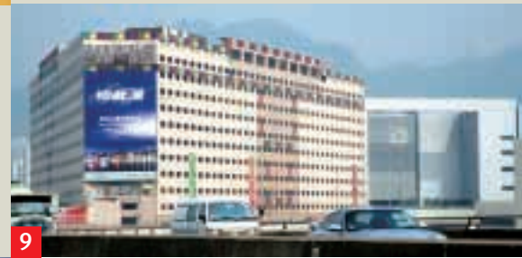
9 香港國際展覽中心 座落九龍灣，樓高 14 層的現代及獨特建築物，建築面積逾 163,000 平方米，備有會議展覽場地、陳列寫字樓、餐飲場所及其他商貿設施等。
