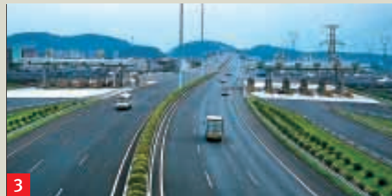
3 珠江三角洲西岸幹道I、II及III期 I期為已完成之全長14.7公里封閉式瀝青路面之雙向三車道高速公路連接廣州市和順德。II及III期正在籌劃中，將分別由順德連接中山市及由中山市連接珠海。
